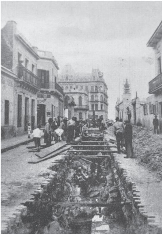
Colector secundario, construido en trinchera abierta, calle Piedras.
